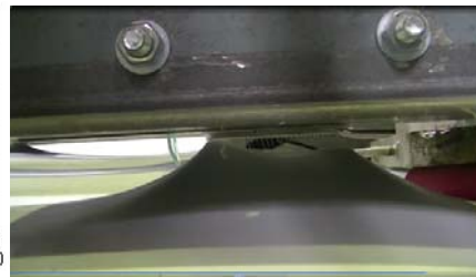
写真2 防水シートの破断状況
